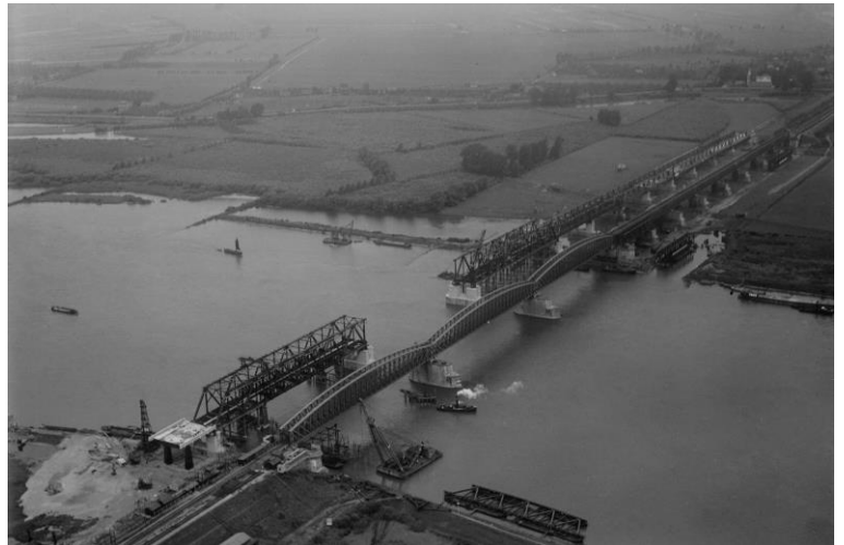
De bouw van de bruggen bij Zaltbommel (1931-1933): verkeersbrug en tweede spoor.
