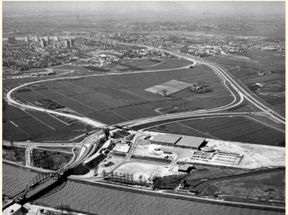
Luchtfoto uit 1978 van de bouw van de remise voor de sneltram bij de Taludweg gezien vanuit het oosten. Op de voorgrond het Amsterdam-Rijnkanaal met de Jutphasebrug en op de achtergrond bebouwing in Nieuwegein. (bron: HUA cat.nr. 843839)
