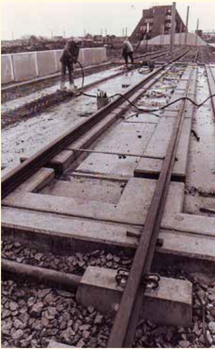
Aanleg tramrails op viaduct over Noordstedeweg. (bron: collectie HKN)
