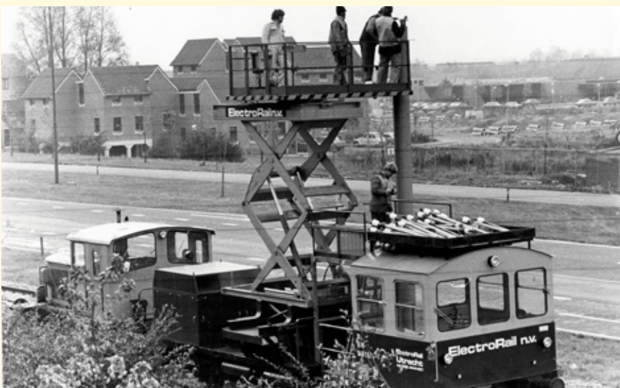
Aanleg bovenleiding bij A.C. Verhoefweg (bron: collectie HKN)
