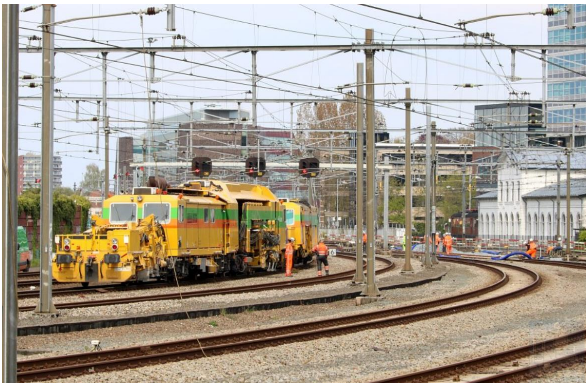
Spoorvernieuwing aan de oostzijde van Amersfoort Centraal met twee stopmachines van spoorwegaannemer BAM Infra Rail. Vooraan BAM Unimat (Universalstopfmaschine) 205. Fotograaf: R.T. Jongerius, Datum:06-05-2021
