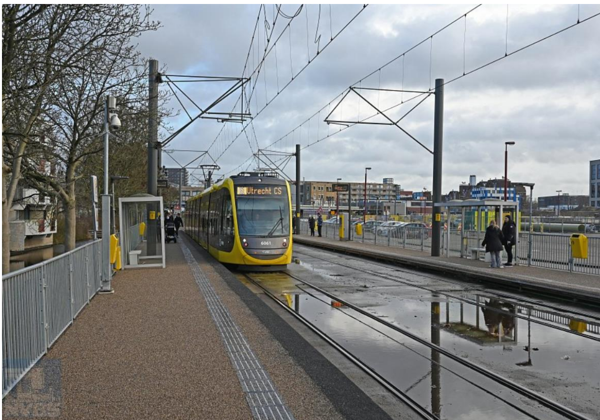
Tram 6061 van de Sneltram Utrecht op lijn 61 richting Utrecht staat aan de tijdelijke halte Nieuwegein Stadscentrum. Bouwbedrijf BAM is begonnen met de bouw van de nieuwe centrumhalte. Die komt te liggen op het terrein rechtsachter op de foto. Fotograaf: G. van Buuren Datum:03-01-2022. Collectie: Stichting NVBS-Railverzamelingen.
