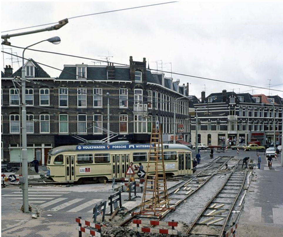
Een PCC motorrijtuig uit de serie HTM 1201-1240 van lijn 6 in de boog van de Herman Costerstraat naar de Delftselaan in Den Haag. Het spoor wordt omgelegd.
