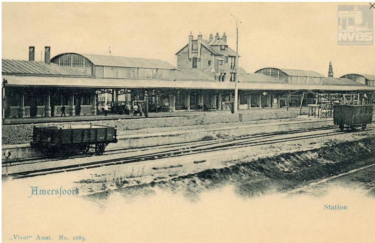
Het overkapt eilandperron van station Amersfoort, met op de voorgrond een open wagen en een personenrijtuig op het kopspoor aan de buitenzijde van het eerste perron waar werkzaamheden plaatsvinden. De kijkrichting is noordoost. Fotograaf Vivat – Amsterdam, Collectie SNR
