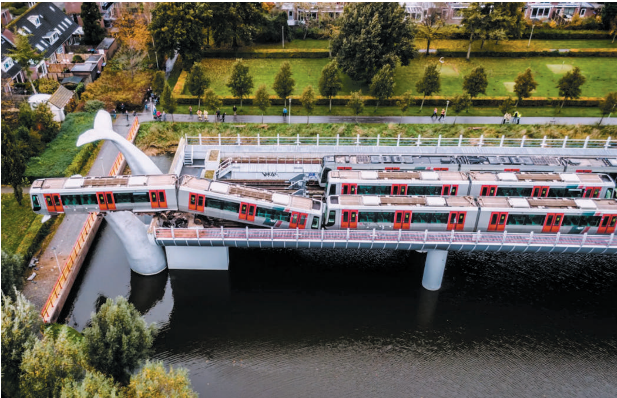
In de kleine uurtjes van 2 november 2020 reed een rangerende metro van de RET door een stootjuk aan het einde van een opstelspoor aan het eindpunt De Akkers in Spijkenisse. Het voorlopende rijtuig 5351 schoot over de betonnen rand van het viaduct en landde op het daarachter geplaatste kunstwerk 'Walvisstaarten' van Maarten Struis. De trein was leeg, op de bestuurder na, die met de schrik vrijkwam. Het kunstwerk bleek zo stevig, dat zelfs de kunstenaar verbaasd was dat de metro erop bleef balanceren. Van fotograaf Jeffrey Groeneweg verkregen wij deze unieke foto, in de ochtend van 2 november 2020 gemaakt met een drone.
