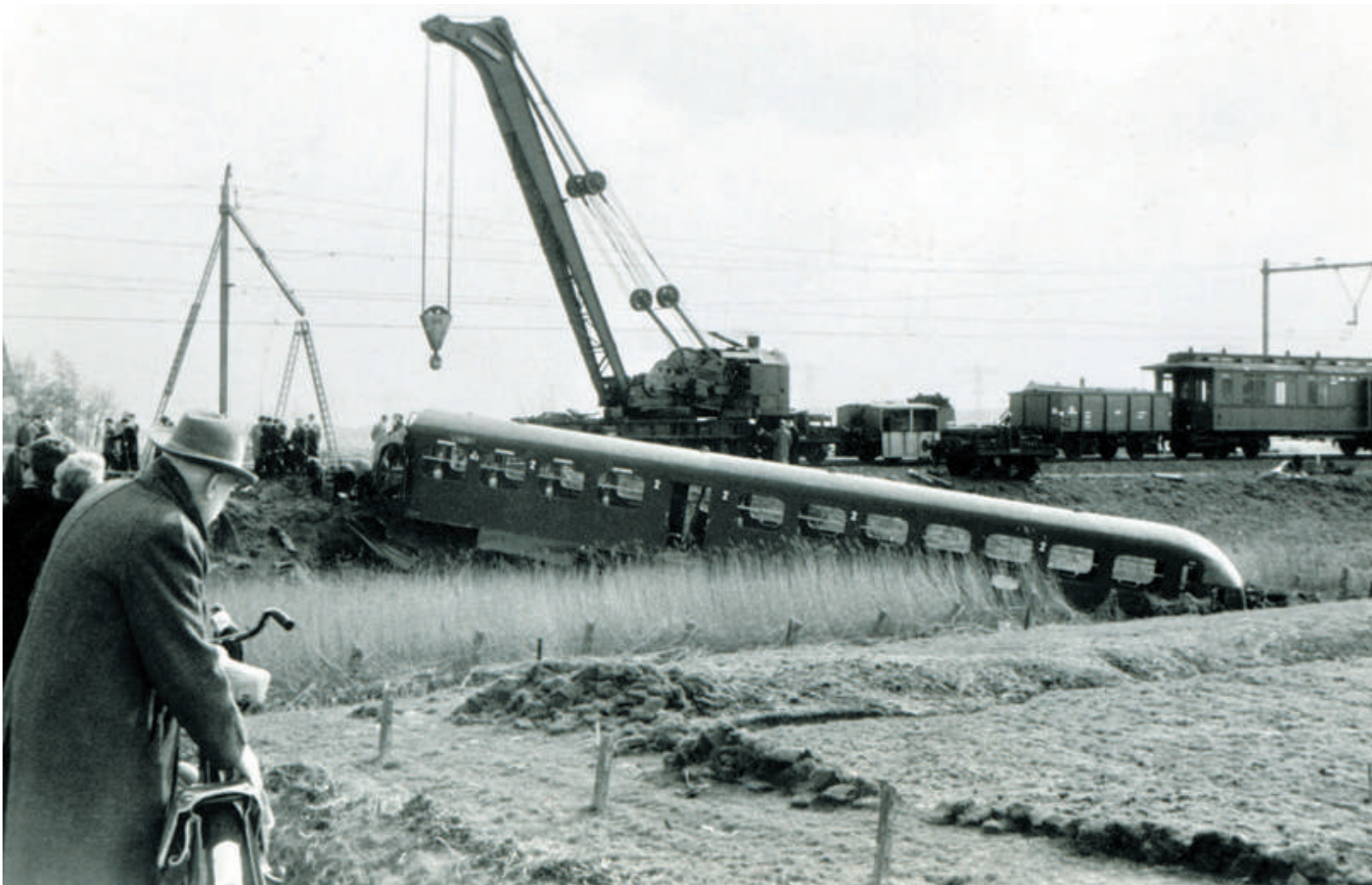
Op 21 maart 1961 botste trein 3016 van Zwolle naar Emmen op een overweg bij Zwolle tegen een vrachtauto, beladen met een bulldozer. De voorste bak van diesel-driewagenstel 153 ontspoorde, ramde een bovenleidingportaal en kwam met de neus in de spoorloot terecht. Als door een wonder raakte niemand ernstig gewond. Op de foto is de Zwolse ongevallentrein met stoomkraan 459 te zien. Maar berging van de toen al 27 jaar oude Bk 153 bleek te ingewikkeld, zodat deze bak in de daaropvolgende dagen ter plekke gesloopt werd. Helaas konden we niet achterhalen wie de maker van de foto is geweest.
