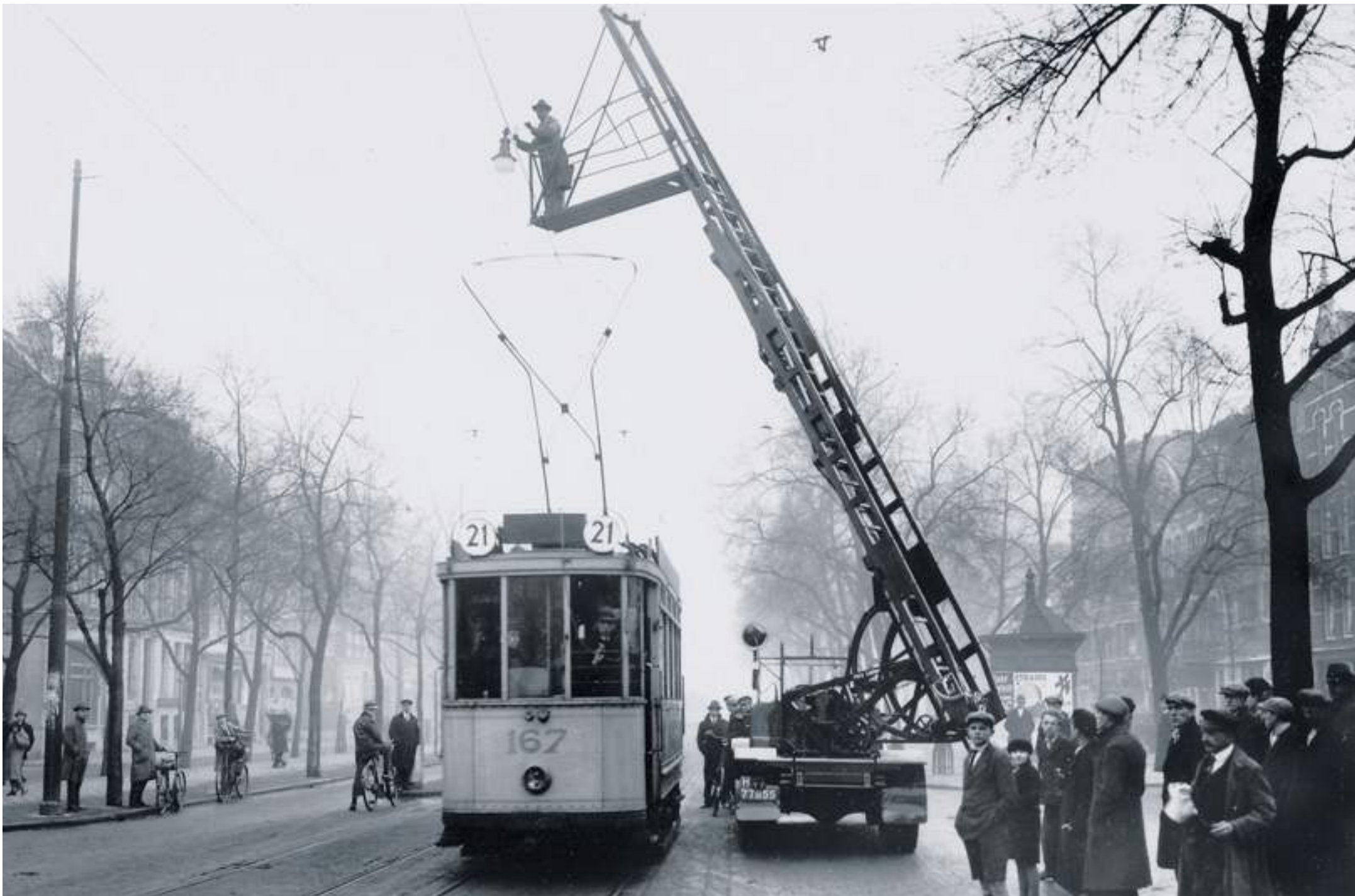
Een man is in maart 1930 niet ver boven de bovenleiding van de tram aan het werk is aan de openbare verlichting op de Goudsesingel in Rotterdam. Samen met de nieuwe, speciaal hiervoor gebouwde, Magirusladder trekt hij veel bekijks. Het is duidelijk dat het nut van zo'n ladderwagen op de gevoelige plaat vastgelegd diende te worden. Tramwagen 167 van lijn 21 (serie 152-176 uit 1914) wacht rustig tot de 'lampenist' klaar is met het spandraadarmatuur. Foto: Collectie SNR.
