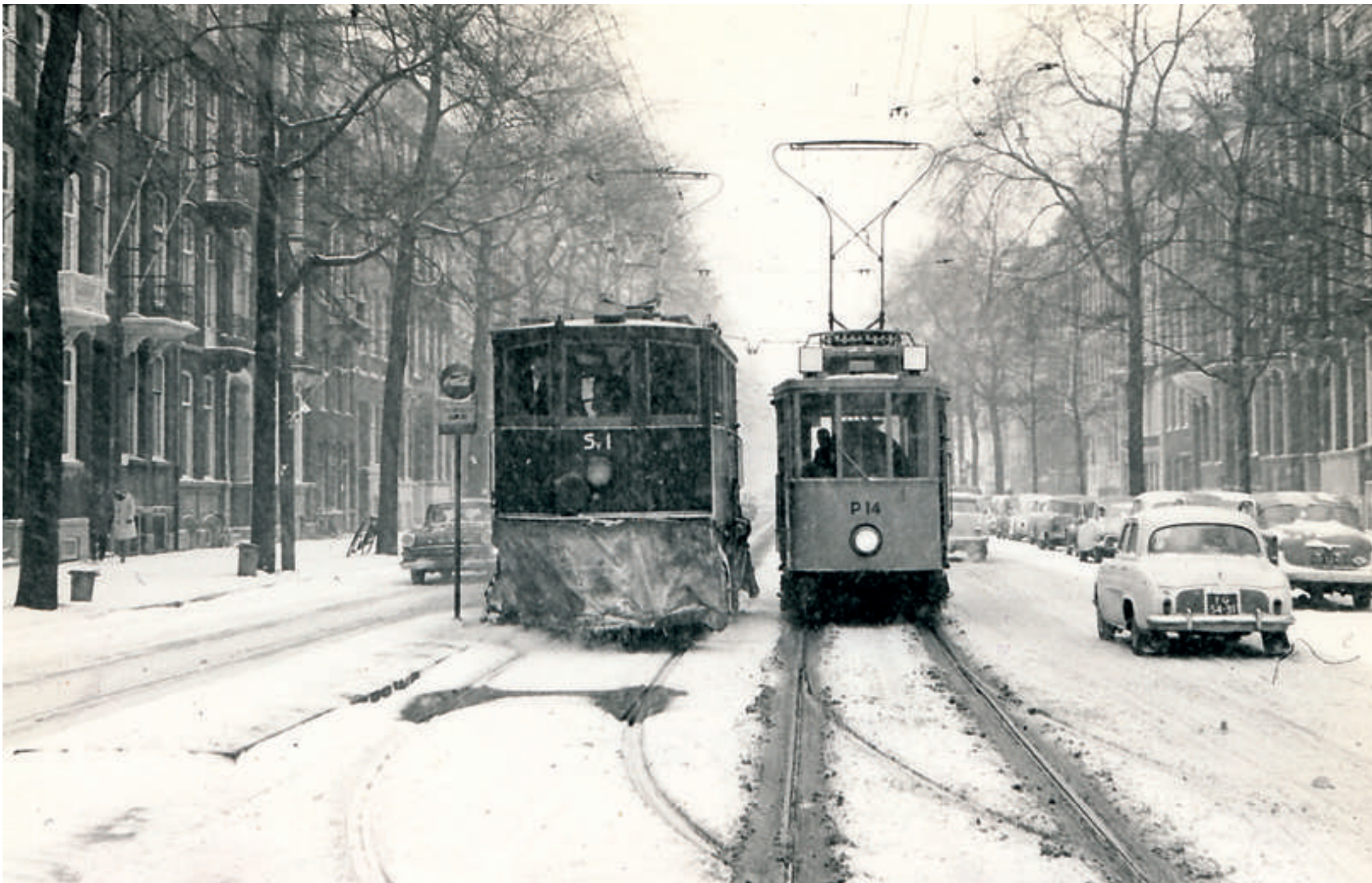
In de winter van 1962/63 had de Amsterdamse sneeuwdienst het druk. Op verschillende dagen werden zelfs de beide sneeuwveegmotorwagens ingezet (Sv1 uit 1905 en Sv2 uit 1912, beide gebouwd door McGuire & Cummings uit Chicago). De 'V' in de sleepbeugel staat niet voor 'Veegwagen' maar voor 'Voorrang'. Volgens instructie dienden wagnvoerders van passerende trams bij nadering van een sneeuwveger hun wagen stil te zetten. De sneeuw op het verwarmde wissel met het afbuigende spoor naar de Roetersstraat is gesmolten. De pekkel uit de tank van pekkelwagen P14 heeft effect op het rechter spoor. Chris Rademaker maakte deze foto in de Sarphatistraat op 30 december 1962.
