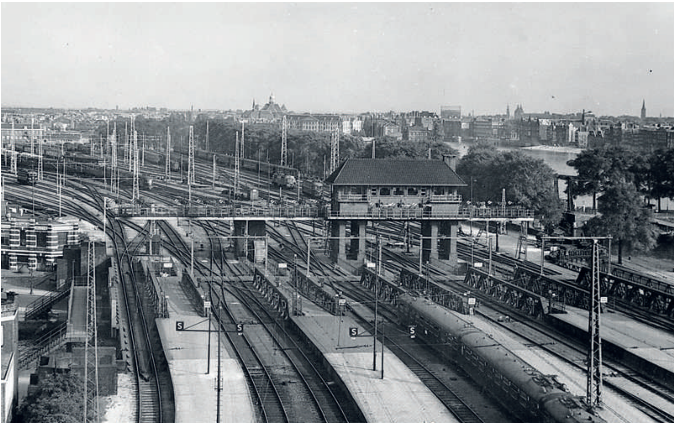
Een foto met een verhaal. Jan de Jongh maakte hem op 28 augustus 1954 vanaf de kap van Amsterdam CS. Het gaat ons om het seinhuis en de seinbrug, maar er is zoveel meer te zien. Een stroomlijnstel staat tot aan het uiterste puntje van het perron. Links van het seinhuis staan locs serie 1000 en 1200. Ook zien we een treinstel mat'46 en een 'grote sik' serie 400. Op de achtergrond is de oostelijke horizon met de Oosterkerk op Wittenburg, en vrijwel in het midden het grote zeemagazijn van de marine, waar nu het Scheepvaartmuseum is gevestigd. De gashouder met bijbehorende gasfabriek lag op de grens van de Watergraafsmeer. Rechts daarvan zien we de toren van de Muiderkerk aan de Linnaeusstraat met het gebouw van het Koninklijk Instituut voor de Tropen. Het hele gebied is drastisch veranderd en van enig uitzicht vanaf dit punt is geen sprake meer.
