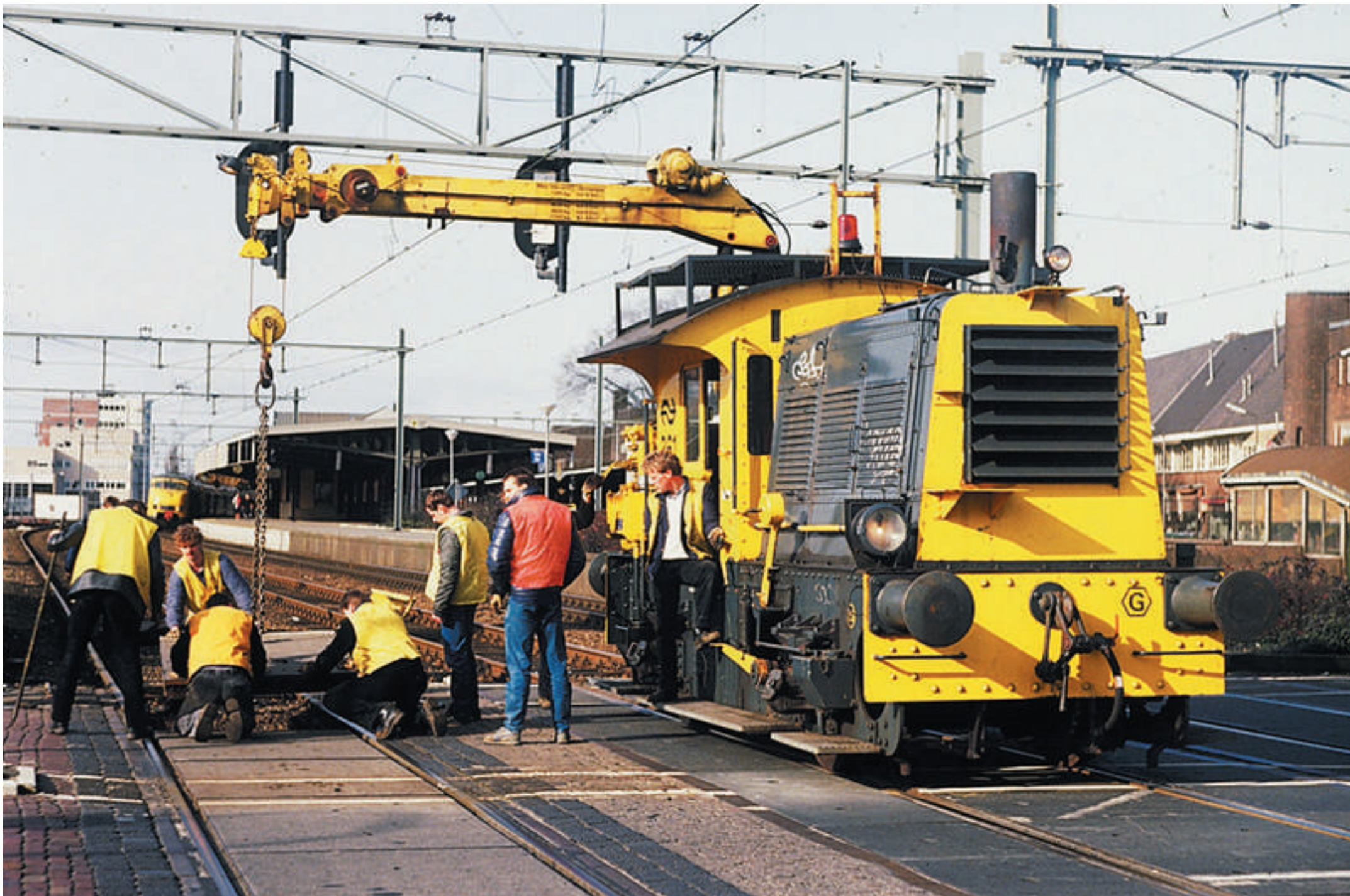
Het centrum van activiteiten in Naarden-Bussum lag op 14 maart 1988 bij de overweg in de Generaal de la Reylaan. In de kraan van Sik 361 hangt een stelconplaat die door enkele baanwerkers wordt geplaatst. De machinist op de treeplank staat in een typische 'sik-houding' met zijn voet op de rem.
