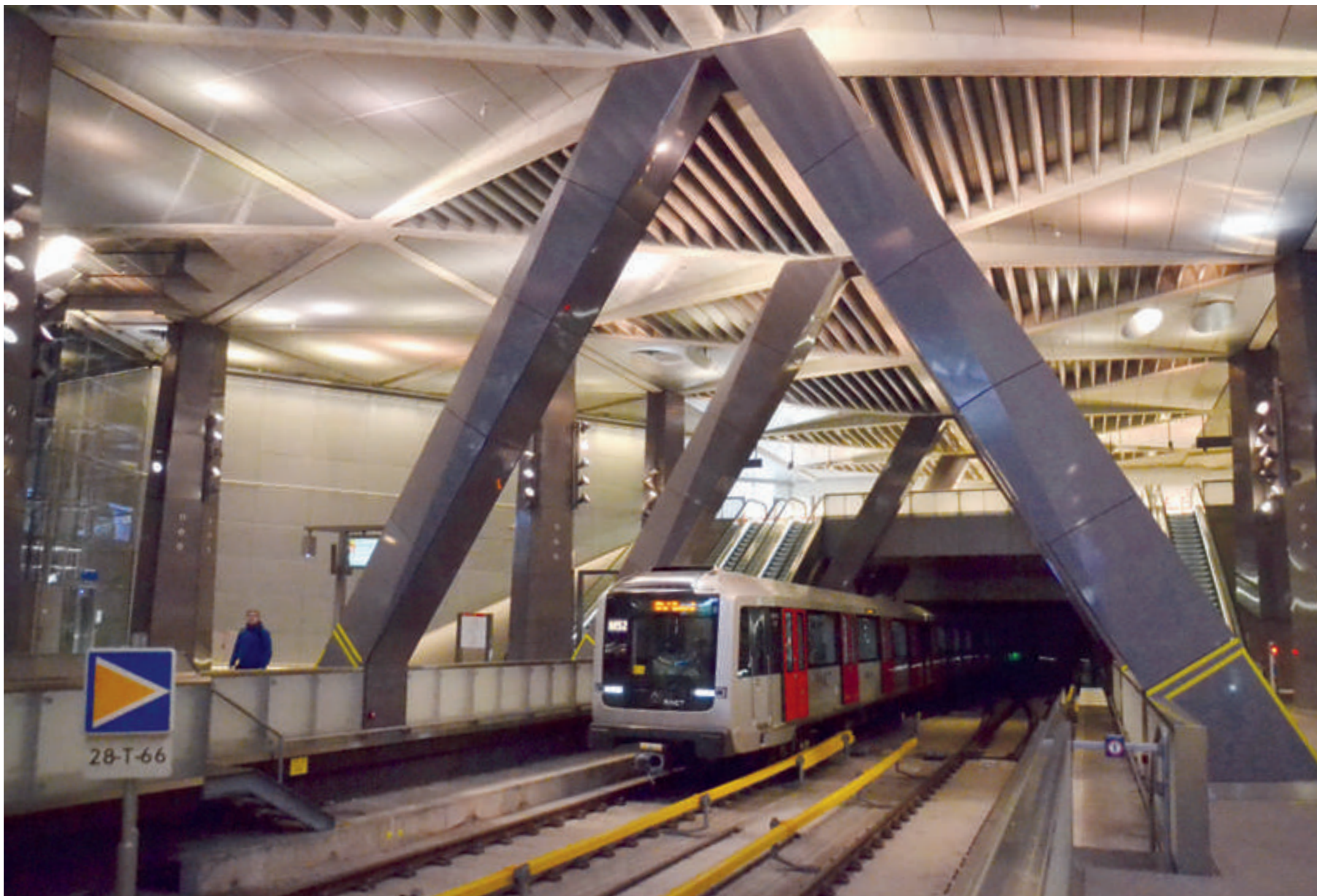
Onder het Stationsplein is een gigantische hal gebouwd die al voor de opening de bijnaam 'Kathedraal' heeft gekregen. M5 metrostel 143/144 rijdt met flinke snelheid de hal binnen. 16 mei 2019.
