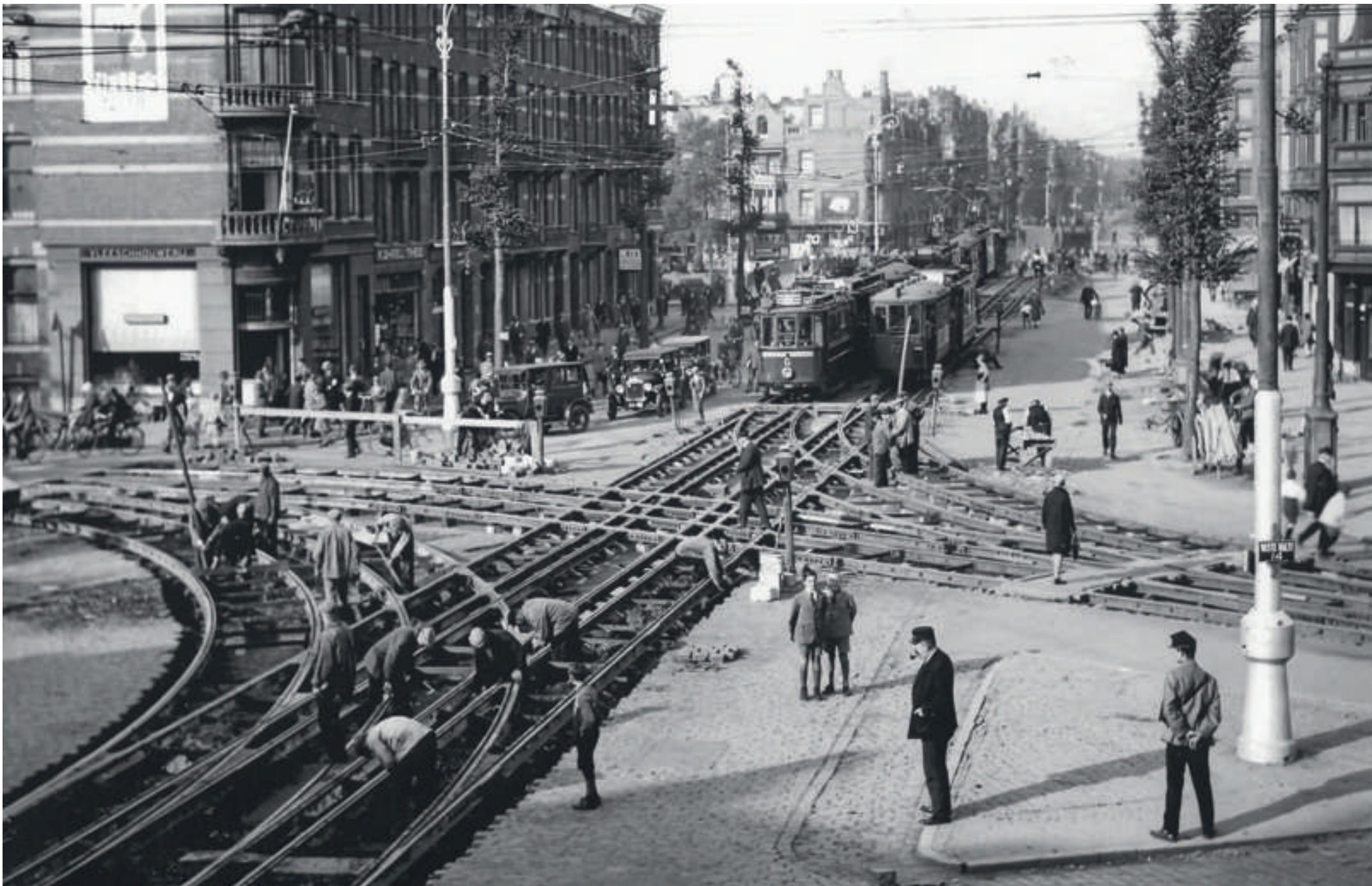
Op de 'Kruising Rozengracht' (een naam die in 1903 bij de tram werd ingevoerd) worden in 1929 de sporen vernieuwd, inclusief de derde rail van de NZH. Lijn 20 met eenmanmotorwagen 6 heeft omgereden via de Bilderdijkstraat wegens de groentemarkt in de Marnixstraat en staat klaar om linksaf te slaan om de normale route weer te volgen. Het derde boogpaar van deze kruising lag dicht tegen de huizen aan en ligt achter ons op deze foto (niet zichtbaar en rechts van dit standpunt).
