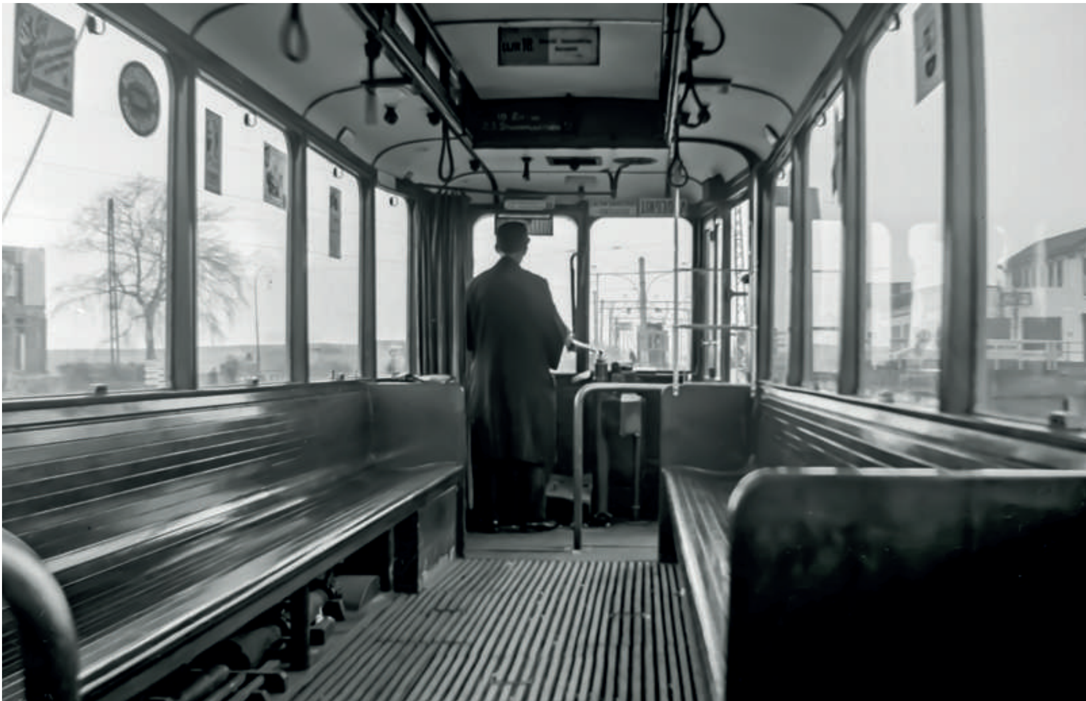
Jan Voerman liet ons deze interieurfoto na van een Bergmanwagen. Er waren niet veel passagiers... Het waren eenmanwagens en daarom was er een soort dodemansysteem aangebracht. De bordjes 'Ochtendabonnement' en 'Vroegrit' zitten opgeklapt achter het frontraam. Onder de bank links zijn de vijzels (nodig bij het in het spoor zetten van een ontspoorde wagen) zichtbaar en een koppelijzer. Heel opvallend is het ontbreken van een balkonscheiding en de enkele deur aan beide zijden. Het was de bedoeling dat de passagiers rechts bij de bestuurder instapten en links achter uitstapten. 23 november 1941.
