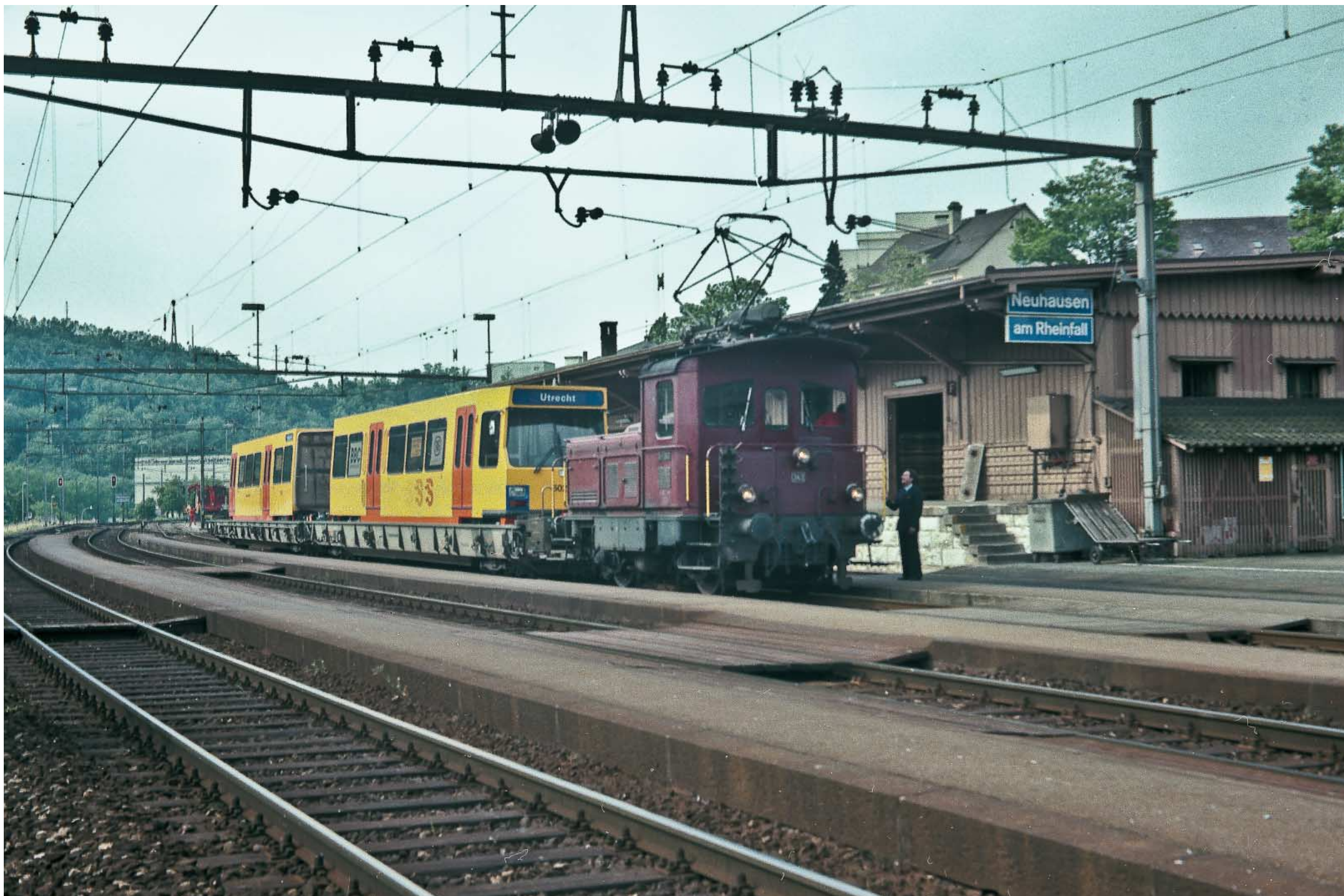
Het nieuwe motorrijtuig NS 5023 voor de Sneltram Utrecht - Nieuwegein wordt in twee delen op speciale goederenwagens van de SIG-fabrieken te Neuhausen am Rheinfall opgehaald door tractor Tem 343 van de SBB; 17 juni 1983.
