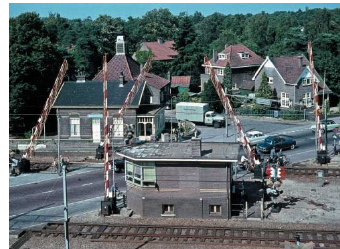
De overweg in de Soestdijkseweg in Bilthoven toont de lange bomen met ‘hangwerk’ in geopende toestand. Vanwege de toegang naar het middenperron zijn extra overwegbomen geplaatst; 9 september 1962. Foto: Kees van de Meene.
