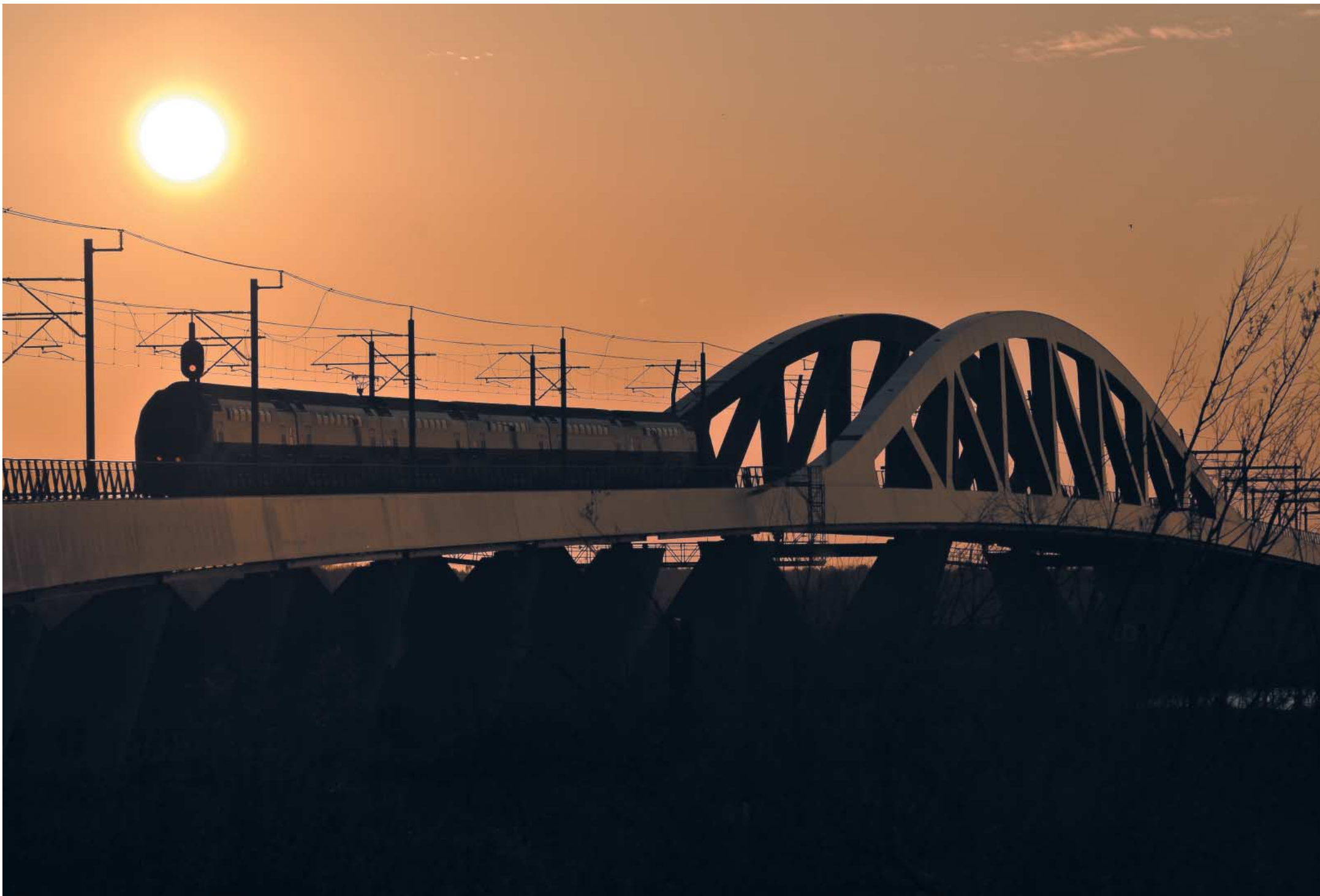
De nieuwe IJsselbrug bij Zwolle gezien vanaf Zwolse kant op 10 november 2014.
