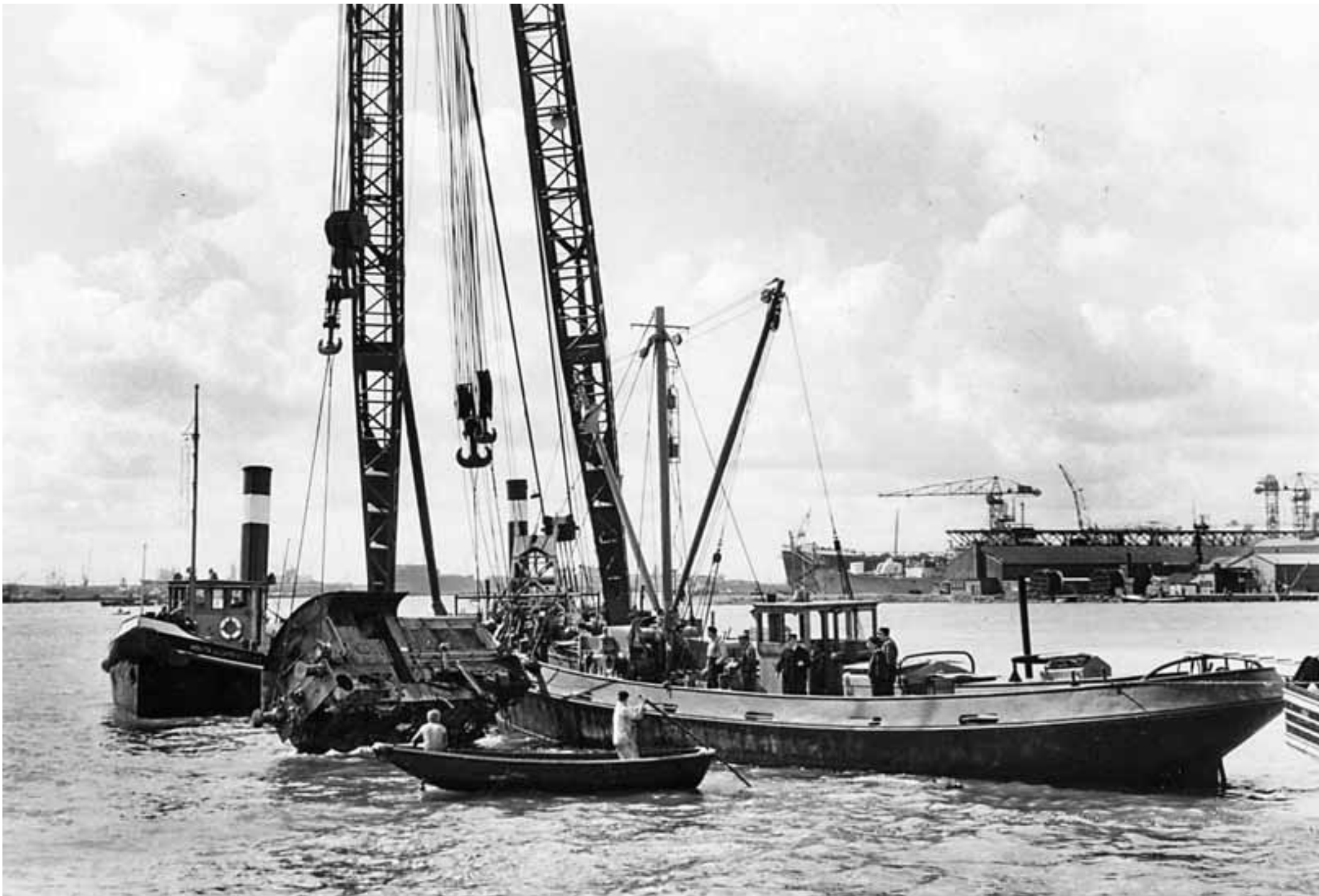
Locomotor 233 wordt door een kraan uit de IJ-haven getakeld na een val van de spoorpont. 11 juni 1957.
