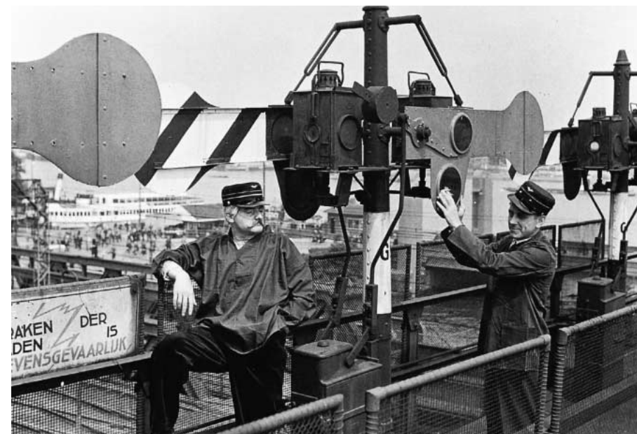
Op de seinbrug bij het seinhuis in Amsterdam Centraal station Oostzijde; circa 1950. Foto: SNR
