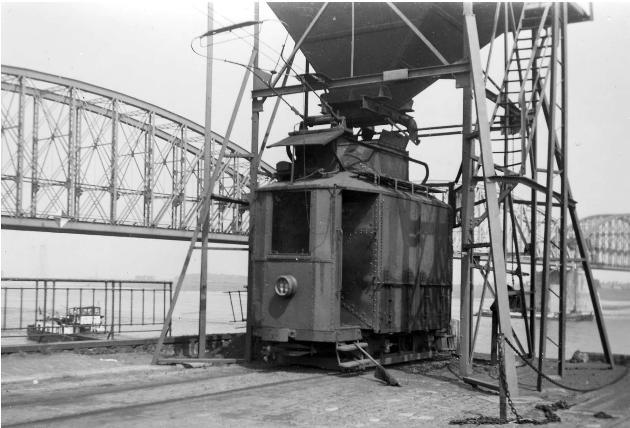
Kolenbunker voor de belading van de kolentram bij de remise van de elektrische tram aan de Waalkade te Nijmegen; 22 juli 1952.
