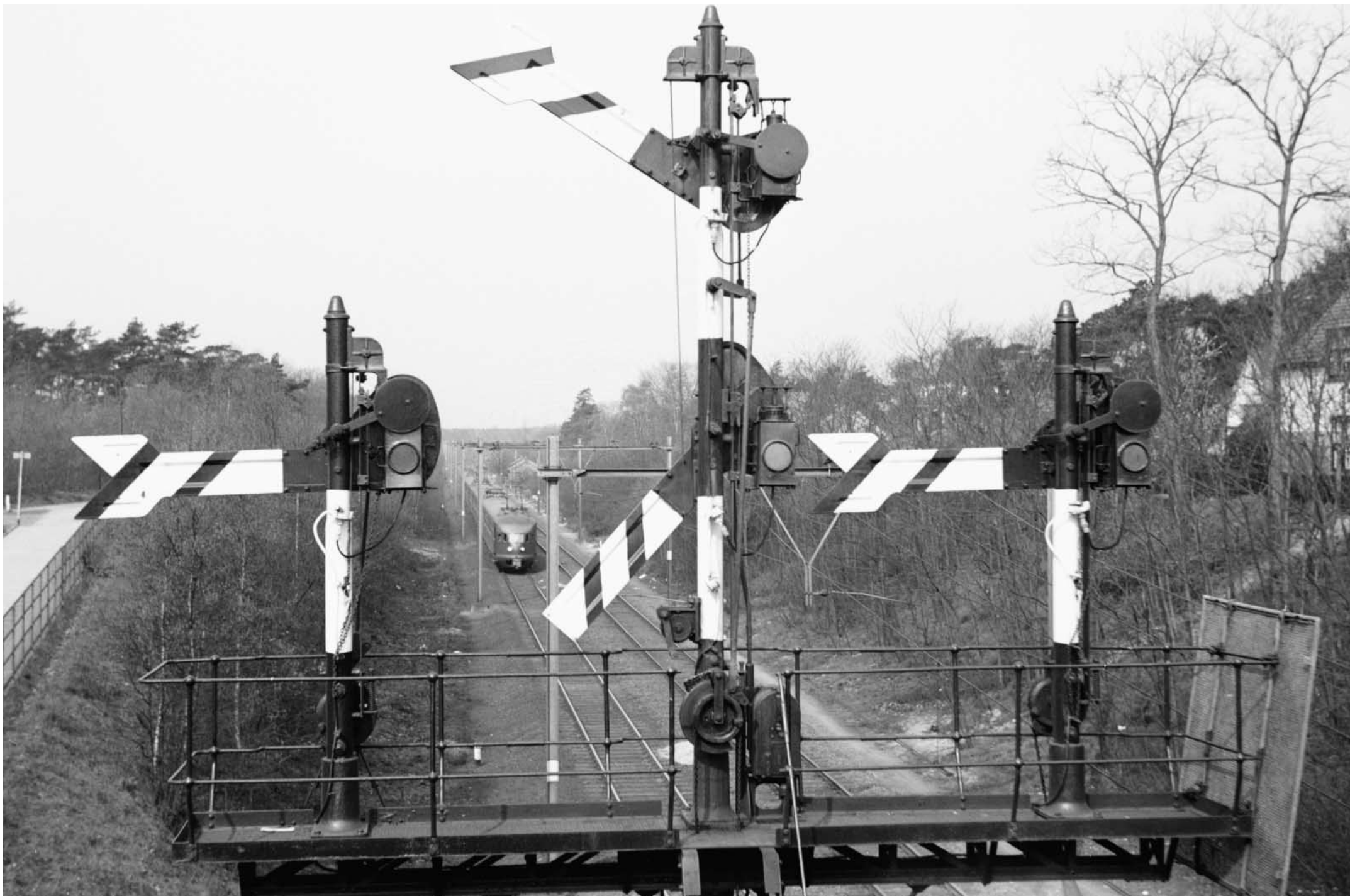
Een seinbrug gezien vanaf het Emmabrug bij het emplacement van Baarn.
