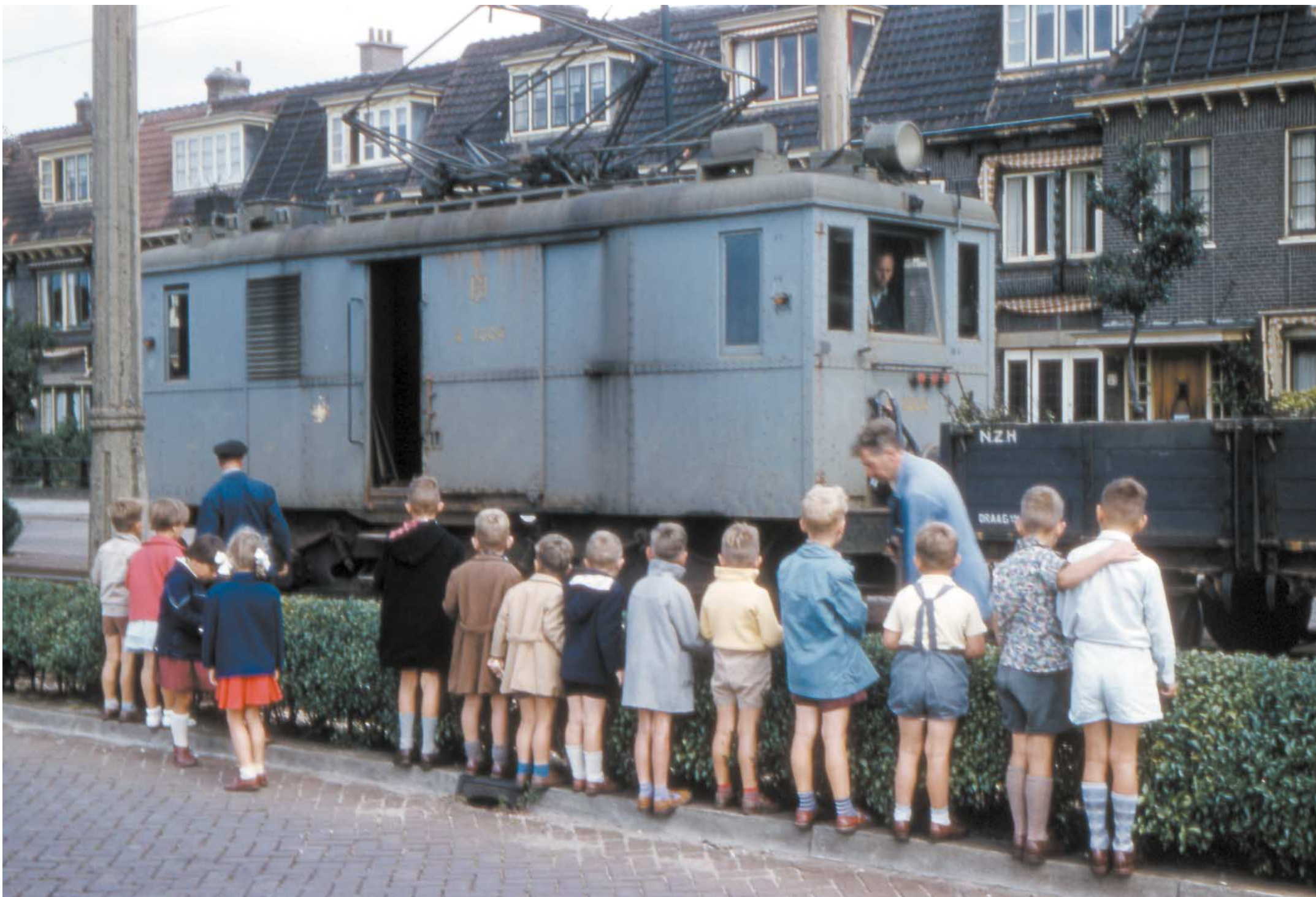
De jeugd kijkt belangstellend toe bij baanwerkzaamheden op de Koningin Wilhelminalaan in Voorburg met werklocomotief A1004 van de NZH; omstreeks 1950.
