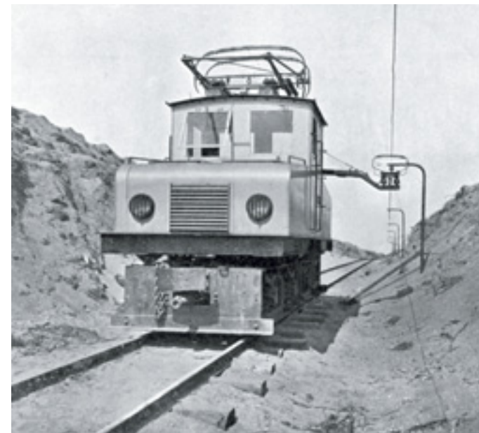
Locomotief van Siemens Schuckert met de speciale zijbovenleiding, circa 1920, foto Siemens-Schuckert
