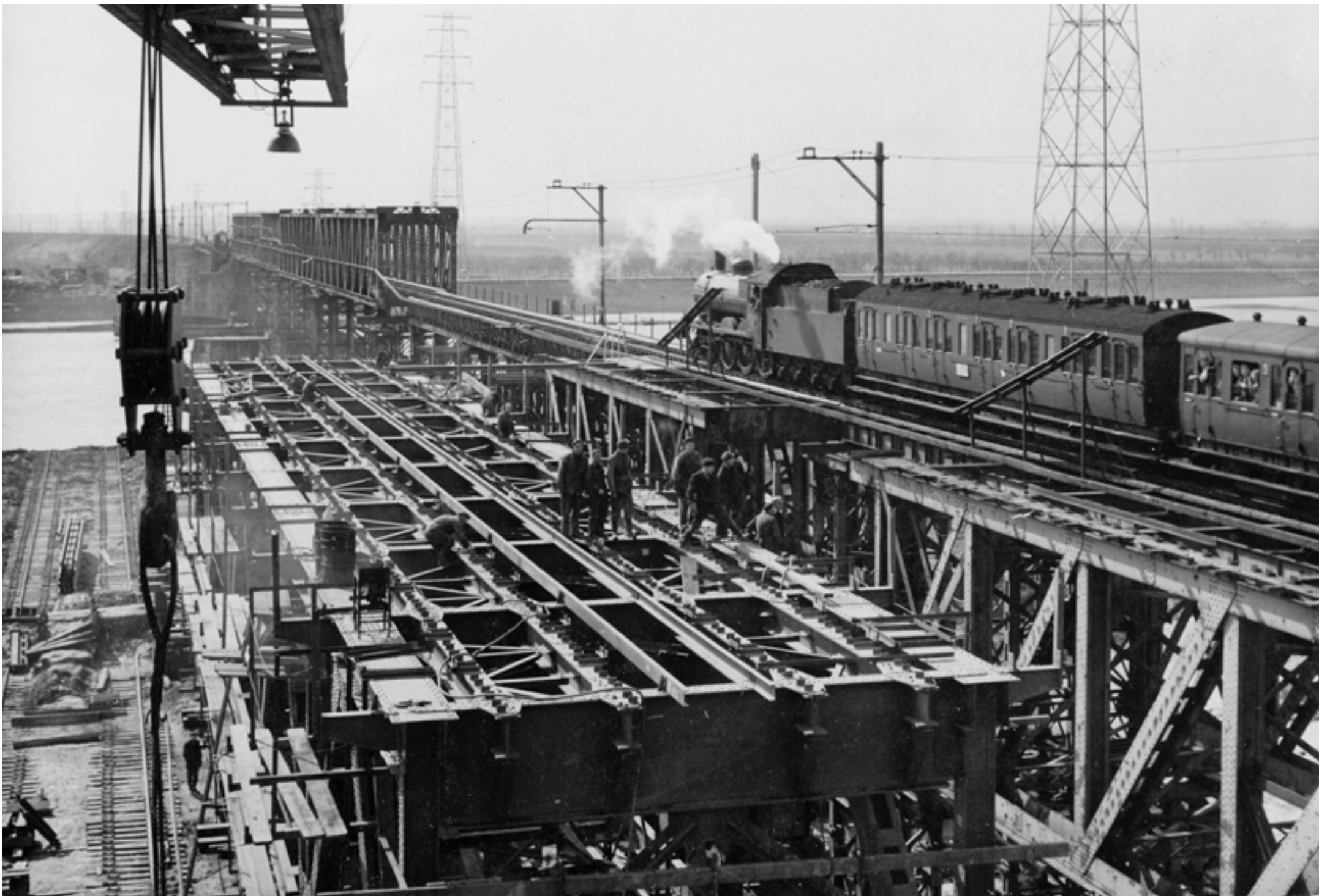
Noodbrug over de Rijn bij Oosterbeek, 1949.
