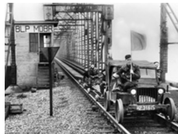
Herstelploeg op de Moerdijkbrug, 19 februari 1953, collectie Karel Hoorn
