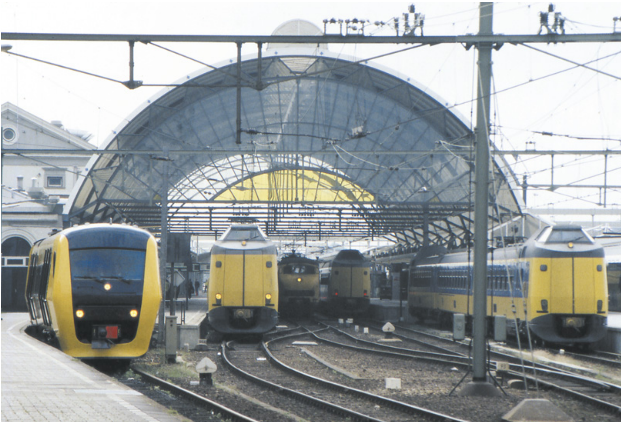
Alle sporen onder de kap in gebruik, 17 juni 1998.
