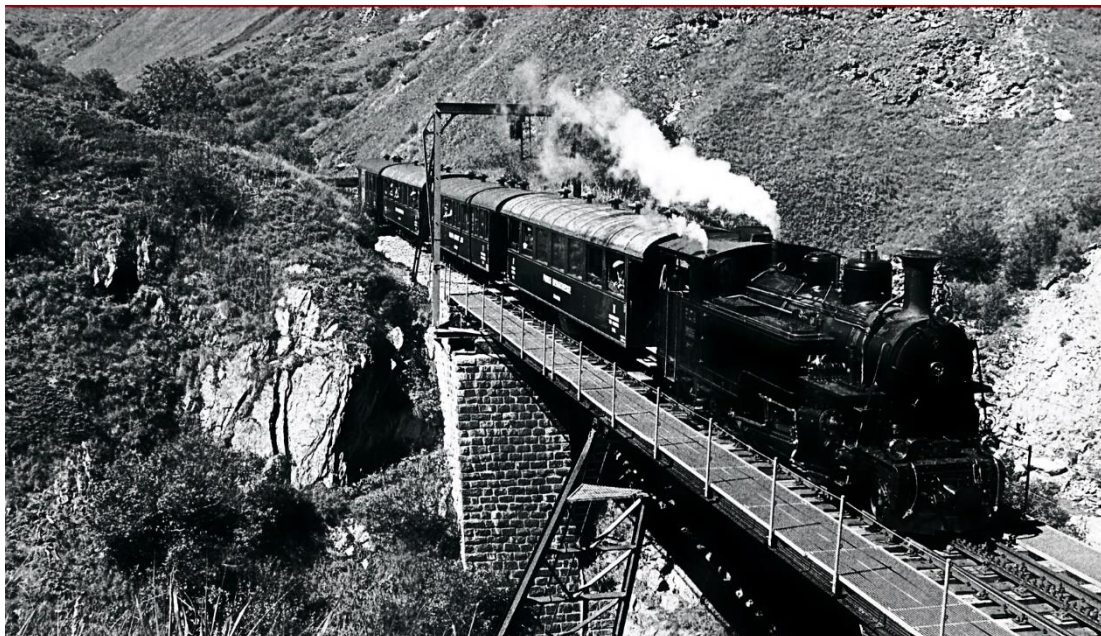
Op de Steffenbachbrücke
