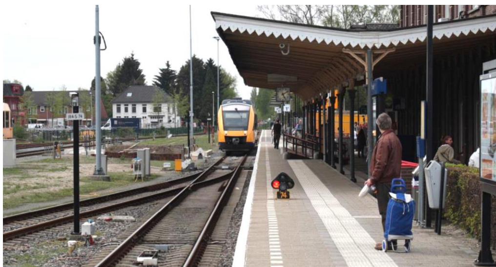
Een bijzonder gebruik van een dwergsein als scheiding tussen de twee lijnen Winterswijk – Zutphen en Winterswijk – Arnhem. Op de voorgrond en vlak voor de LINT een ATB-NG baken. Foto: JT, 2012.
