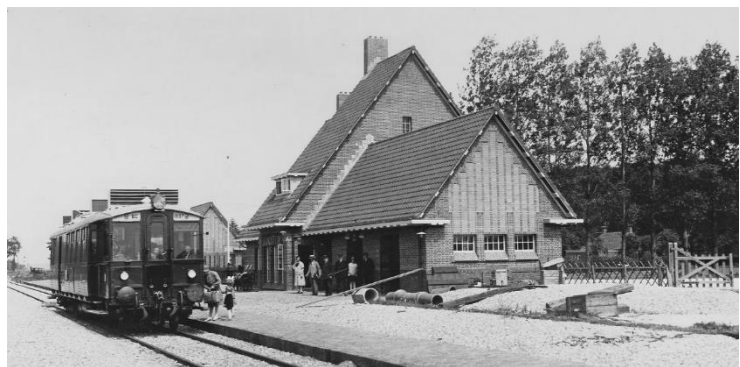
Slochteren, NS omBC 1907 (1929, Werkspoor), stationsgebouw, Woldjerspoorweg Groningen - Weiwerd, Foto P.B. Kramer, 1929
